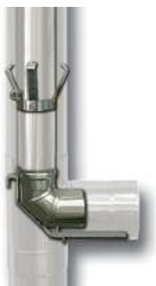
Montaż rury spalinowej turbo za pomocą specjalnej obejmy centrująco-montażowej.
